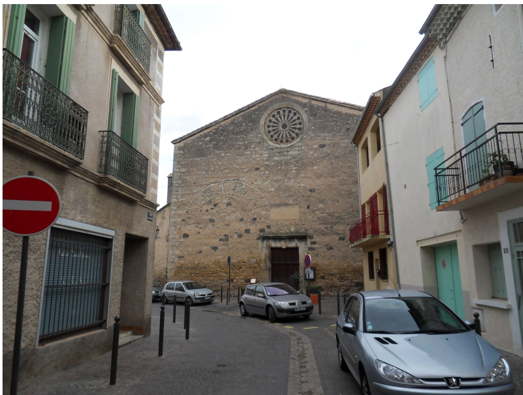
Photo 3 – Vue vers l'entrée principale de l'église – Enchâssement du monument dans le tissu urbain ancien
