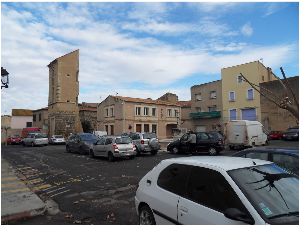
Photo 9 – place Gabriel Péri – vestiges de la tour nord de l'ancien château seigneurial
