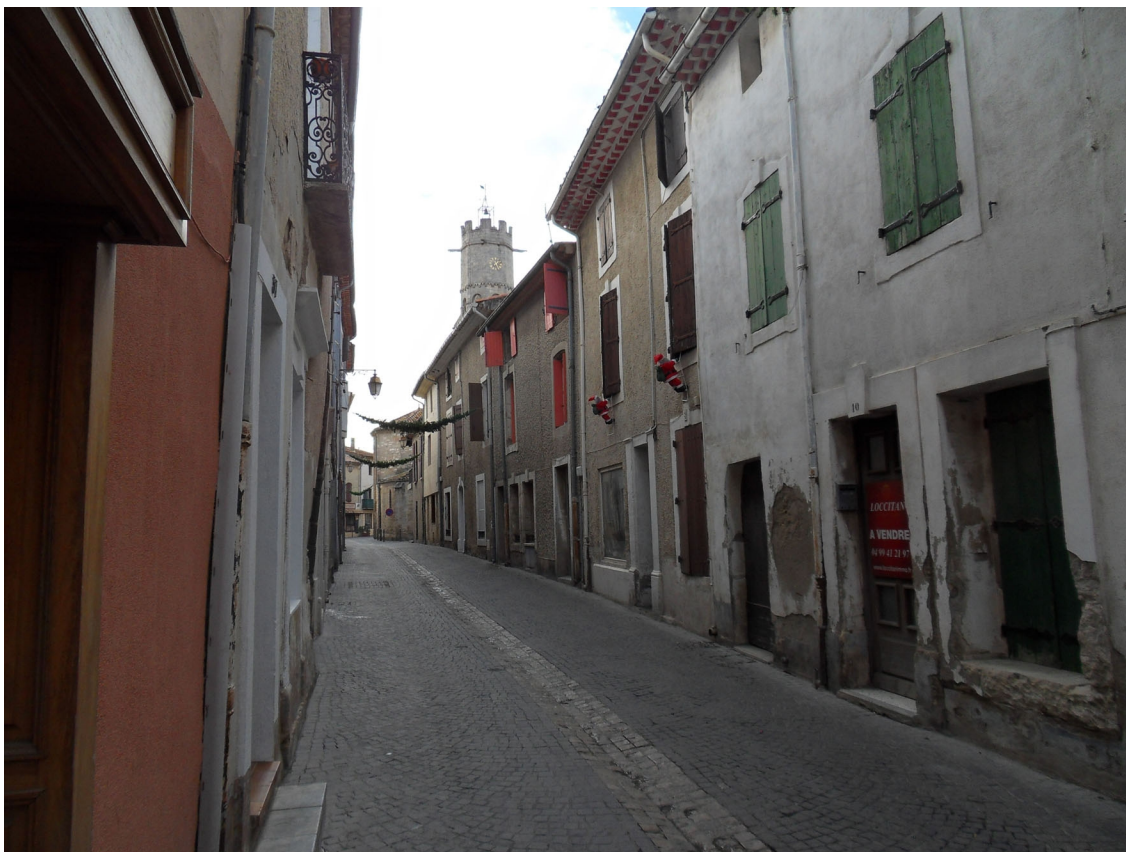
Photo 12 – Vue sur le clocher depuis la rue du 4 septembre L'aspect des façades a un impact immédiat sur la qualité des vues sur le monument.
