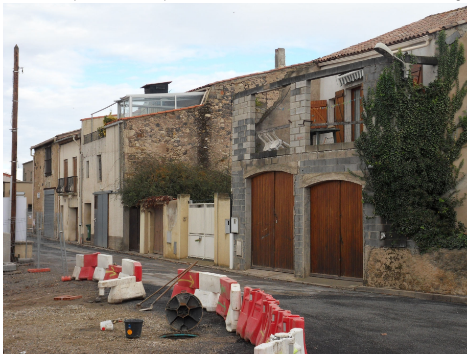
Photo 36 – pour éviter des altérations, en particulier nombreuses sur le tour de ville.
