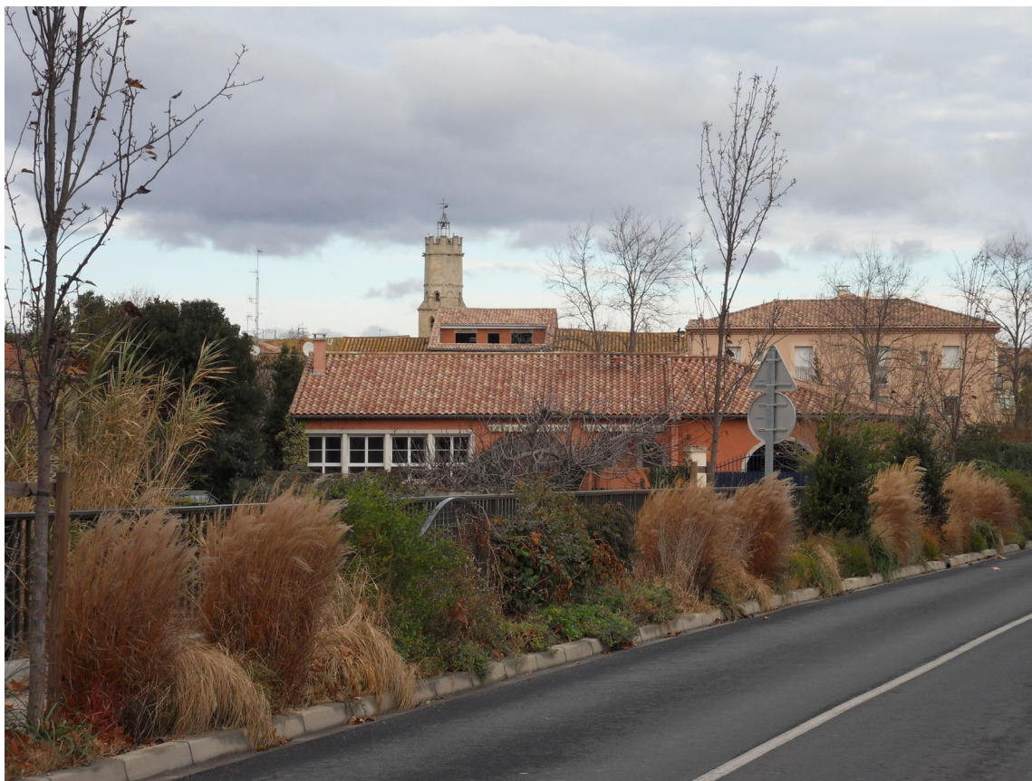
Photo 20 – Vue depuis la RD37 – Impact d'une surélévation
