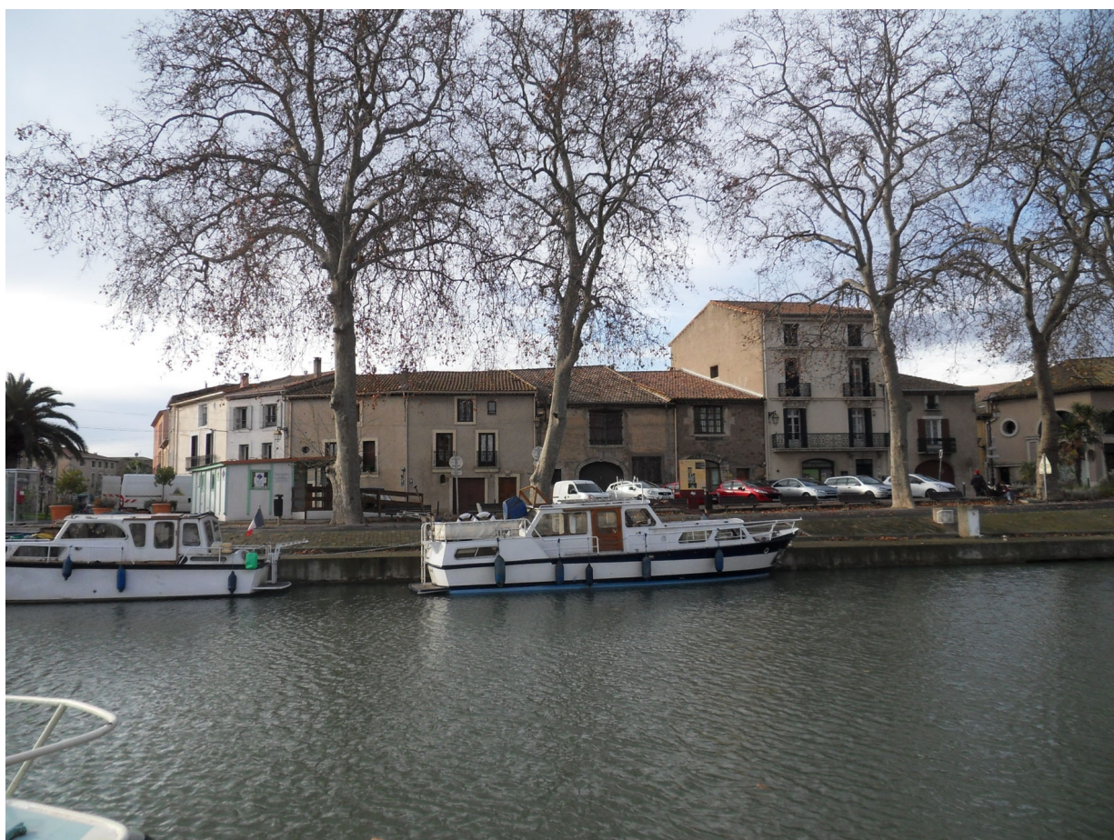
Photo 16 – Continuité urbaine et alignement de platanes le long des berges du Canal du Midi
