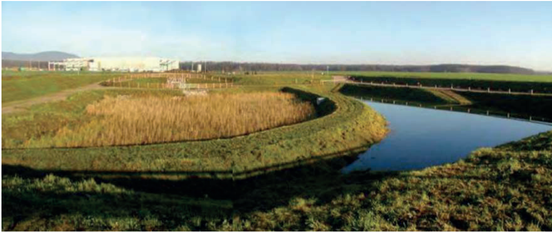
FILTRES PLANTÉS, AVEC BASSIN PAYSAGÉ EN SORTIE DAMBACH LA VILLE (BAS-RHIN), ZONE D'ACTIVITÉ
