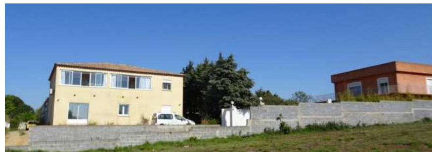
Bâtiment présent au nord de la zone d'étude pouvant accueillir des chauves-souris anthropophiles – CBE, 2021
