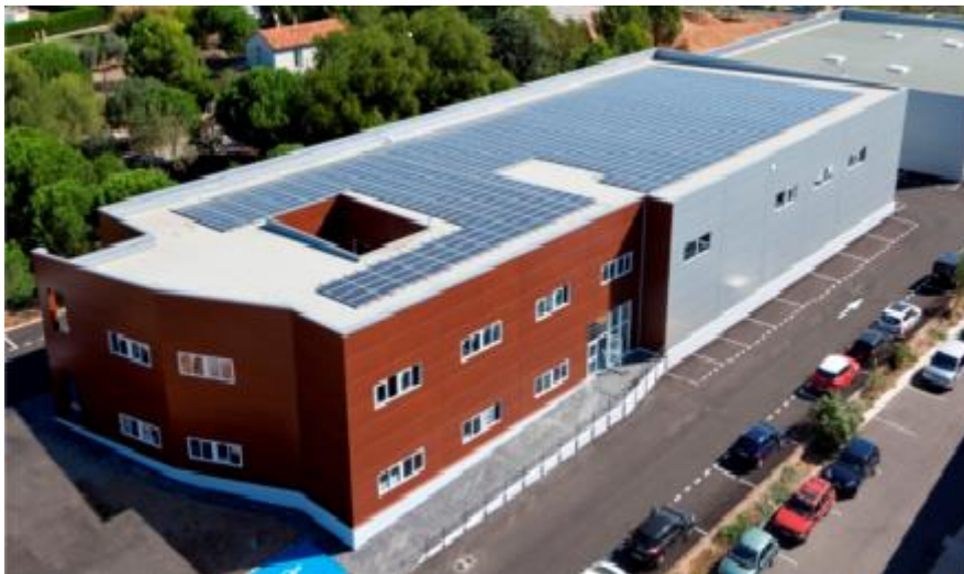
PV sur toiture plate - Photo DR
