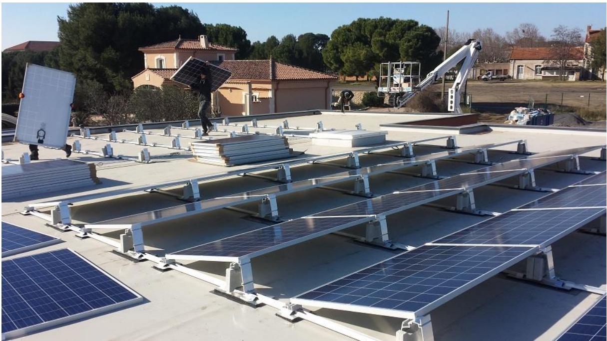
Bâtiment de bureaux – toiture plate (34) - Photo DR
