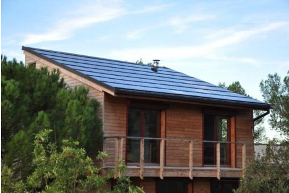
Maisons à énergie positive – toiture monopente en tuiles photovoltaïques - Les Matelles (34) Photo L. FAREVEL/PLUS DE VERT
