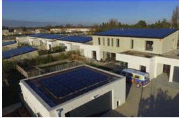
Lotissement à énergie positive – toitures monopente ou plates - (Bouches-du-Rhône)
